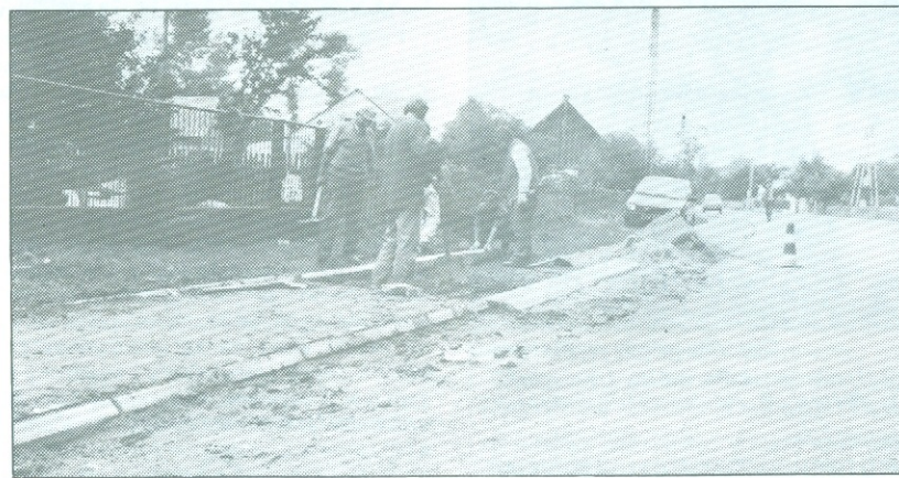
Układanie chodnika w Ościslowie
